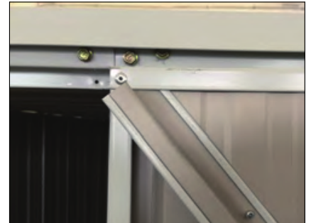
Door Bracing - Top
